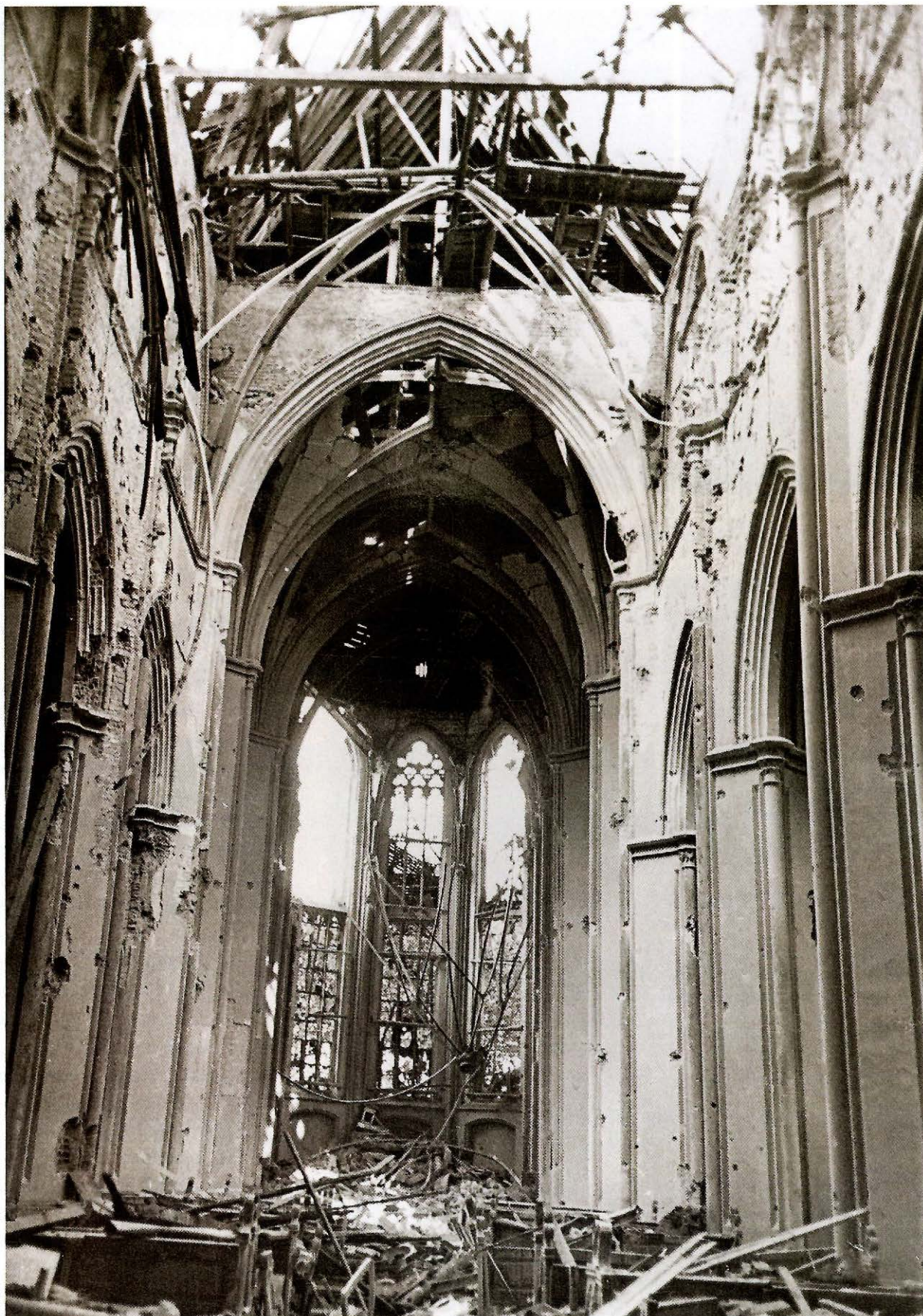
Am 27. August 1944 wurde die Kirche durch drei Volltreffer zerstört. Nur der Turm und die Außenwand an der Südseite blieben stehen. Inmitten der Zerstörung stand der Stahltabernakel unbeschädigt, so dass Pfarrer Siemons das Allerheiligste bergen und in das Pfarrhaus tragen konnte.
